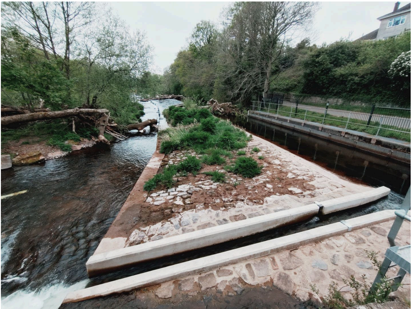
Newtoni paisule rajatud kanal kalade allavoolu pääsemiseks Usk-i jõel. Huvitav oli ka Newtoni paisu lahendus – see oli ehitatud väga pikalt piki jõge – selle põhjust ei osanud kahjuks keegi meile selgitada. Foto: Tuuli Teppo
