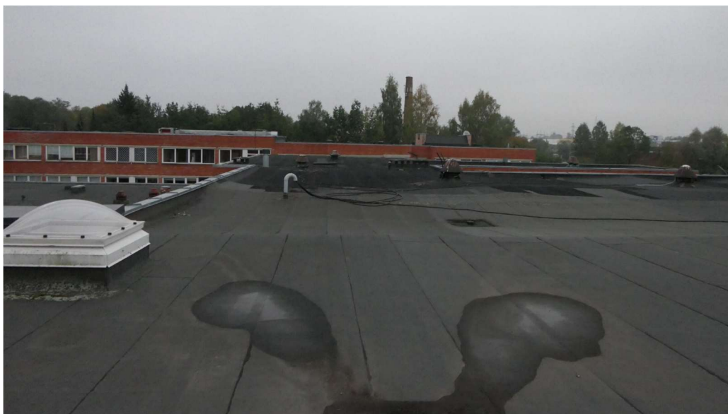
Joonis 13. Sademevee kogumine veelabori lamekatuselt
