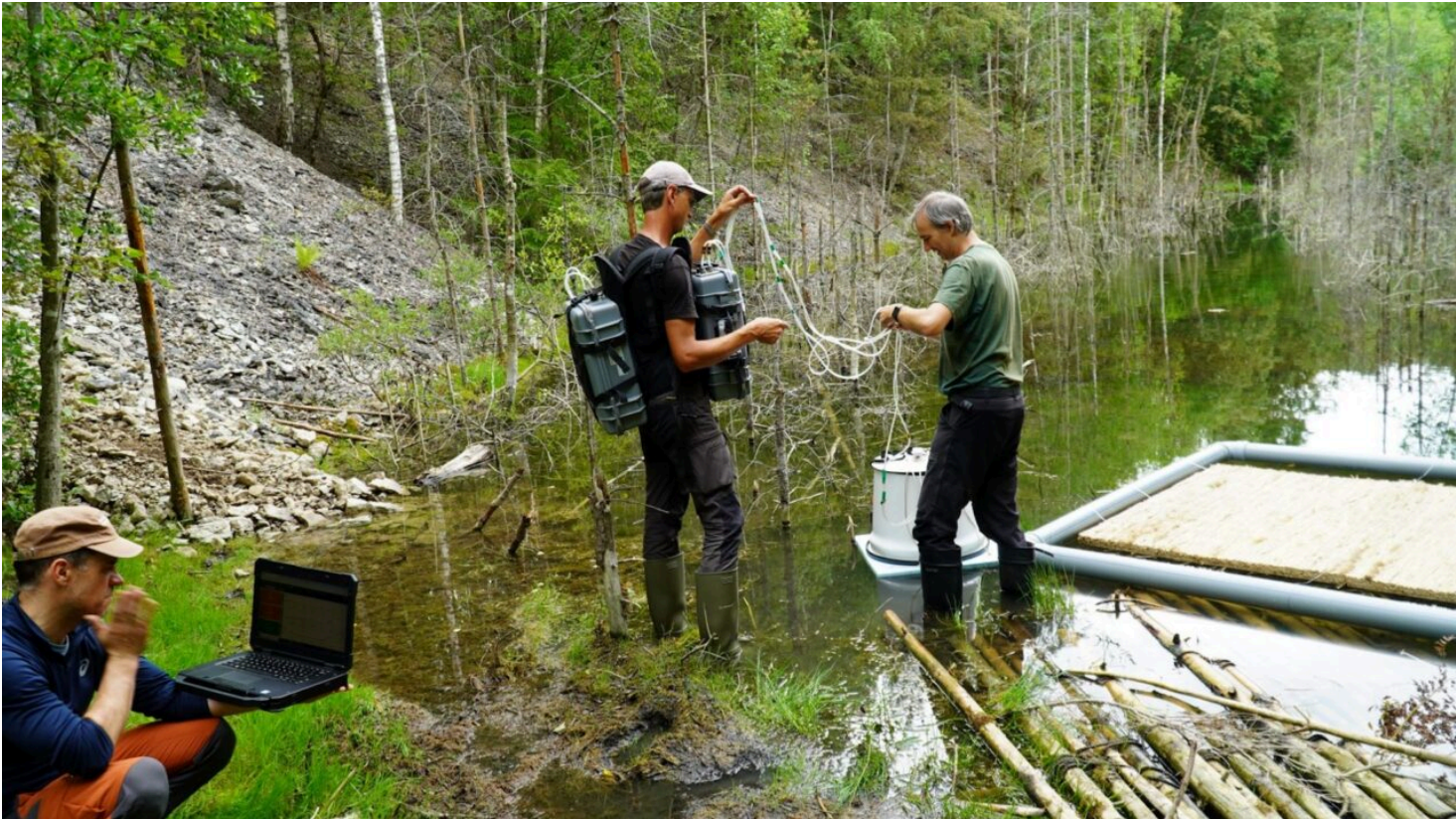
Teadlased Aidu kaevandusjärvele ujuvsaari paigaldamas. Foto: LIFE-SIP AdaptEST / kliimaministeerium
