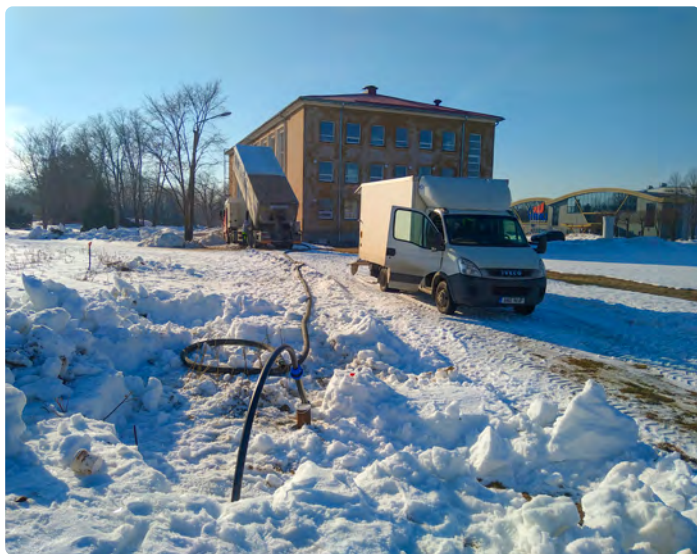
Täitesegu segamine ja pumpamine kaevandusse läbi selleks puuritud tagasitäite puuraukude. Foto: EGT.
