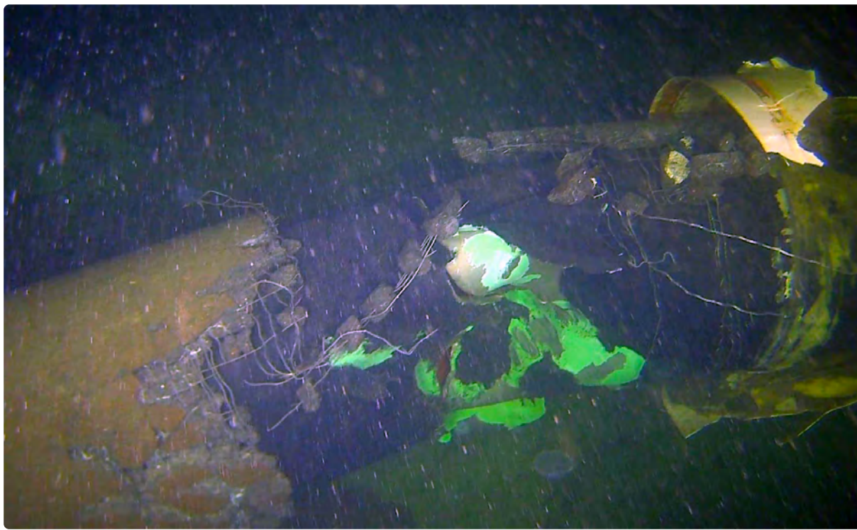
Kahjustused Balticconnector'i maagaasitorul, mis asub Ingå (Soome) ja Paldiski vahel. Foto: Rajavartiolaitos (Soome piirivalve)).
